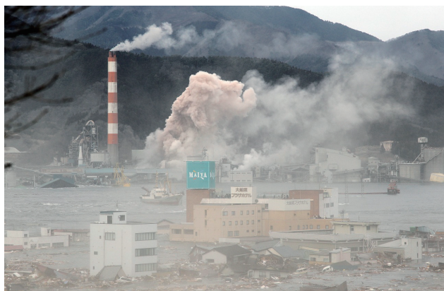
震災時の工場（水蒸気爆発で焼成炉から原料が噴出）
