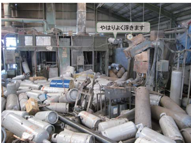
図5 LPG容器再検査工場 (3月19日撮影)
