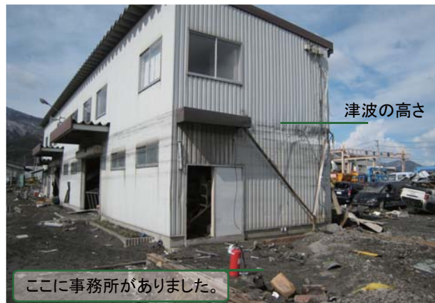
図3 事務所と倉庫 (3月19日撮影)
